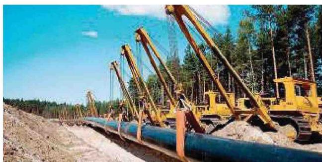
PIPELINE Un cantiere della Bonatti .
